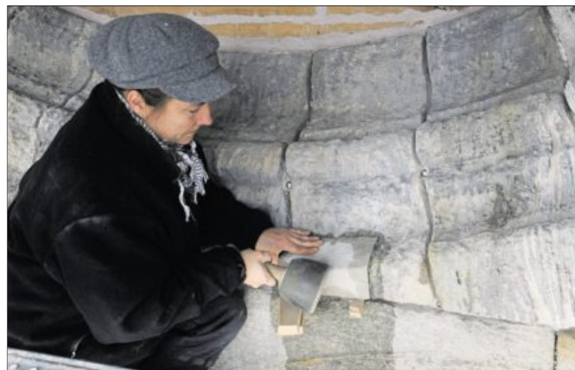
Echte Handarbeit: Die Steinmetzin klopft ein Ersatzteil millimetergenau ein.
